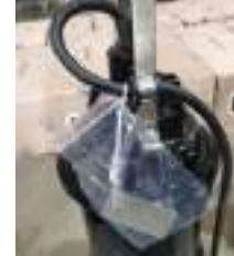
Кабель зафиксирован зажимом
