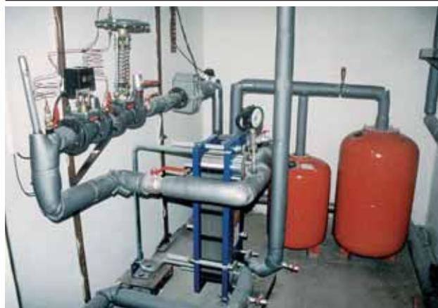
Рис. 2. Тепловой пункт здания с приборами автоматизации фирмы Danfoss
