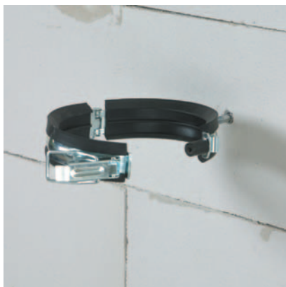
Рис. 4-1 Смонтированный опорный хомут
